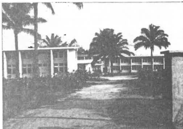
O seminário maior de Brazzaville. (A estrada de acesso já foi arranjada e posto um portão na entrada.)
