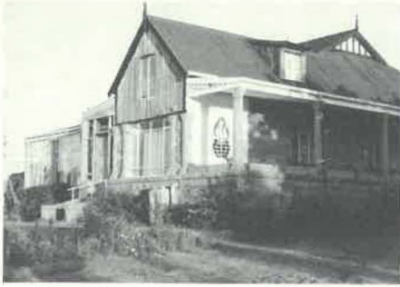
Glen Ash: La maison principale.
