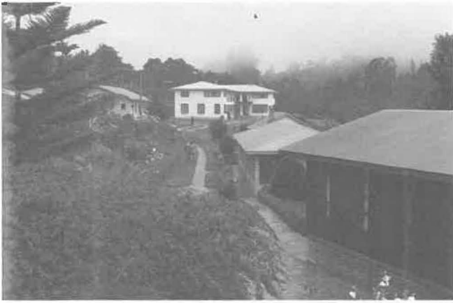
Africa-Leste: Noviciado de Magamba — ao fundo, o novo edifício.
