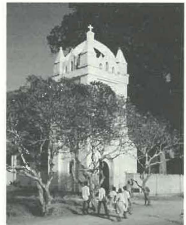
Tour de la 1ère Eglise construite en 1872
